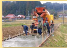
未舗装農道の舗装
